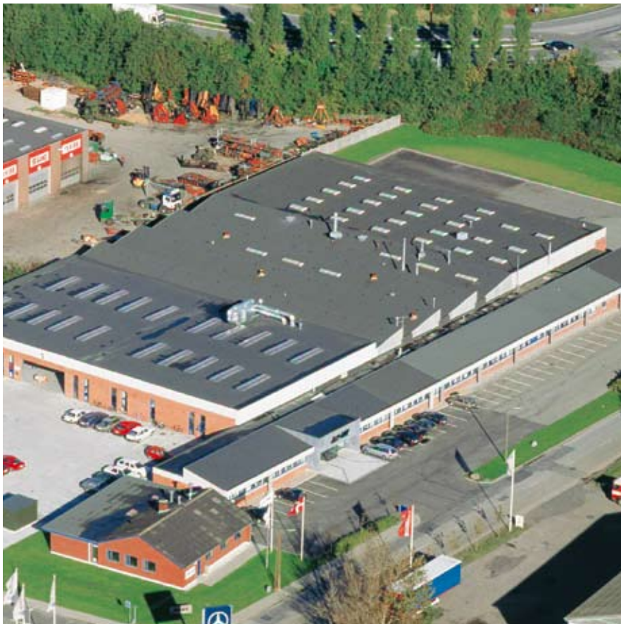
JUN-AIR Betriebsgelände in Dänemark
