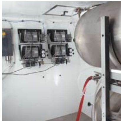
Druckluftversorgung einer Getränkezapfanlage
